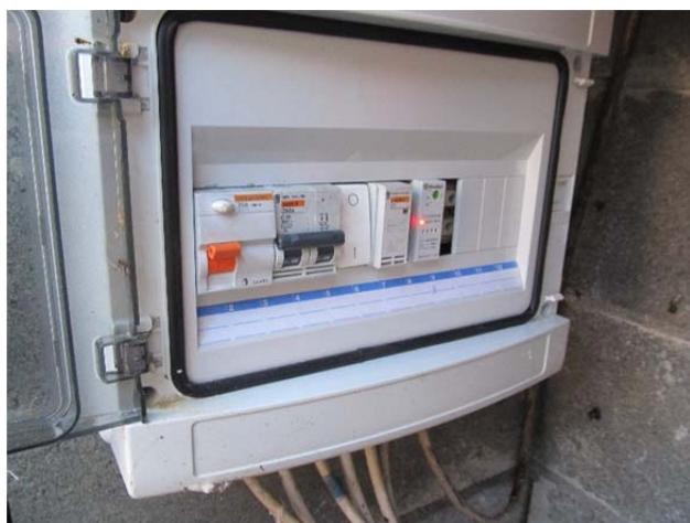
Quadro IP Comunale in Classe II, in esecuzione da parete (buono)
