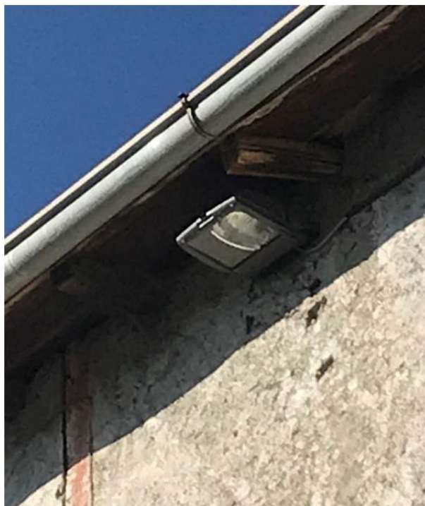
Apparecchio sottogronda per lampada ad alogenuri metallici installato a parete
