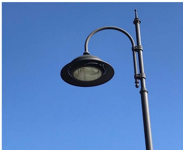
Apparecchio decorativo con vetro di chiusura piano per lampada al sodio installato su palo zincato
