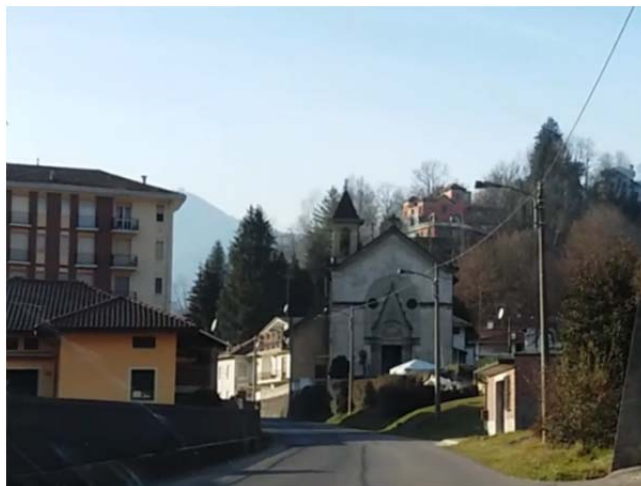
Punti luce di recente installazione a LED di proprietà ENEL installati a Pray in via Roma
