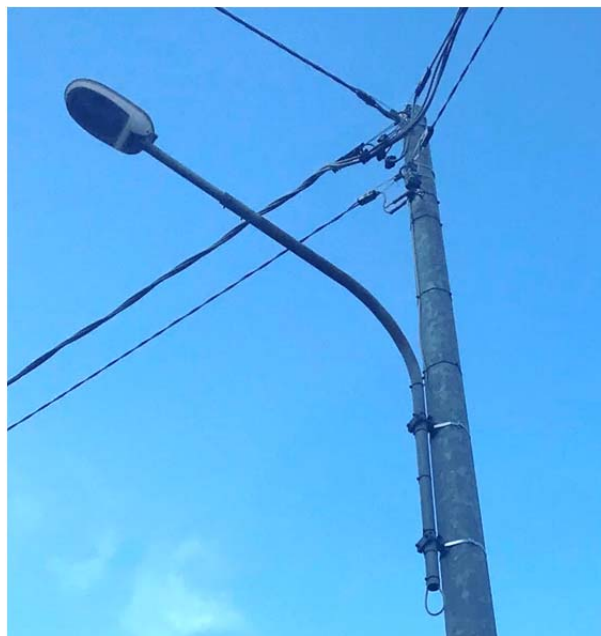
Armatura stradale con vetro di chiusura piano per lampada al sodio installata su palo zincato
