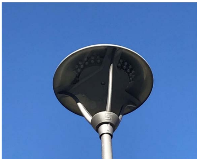
Apparecchio decorativo per sorgenti LED installato su palo zincato
