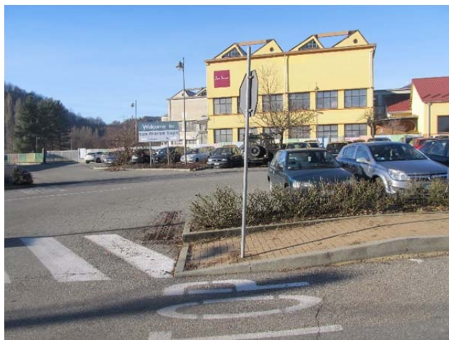
Punti luce di recente installazione con lampada al sodio ad alta pressione installati in via Carducci e via D. Alighieri a Pray
