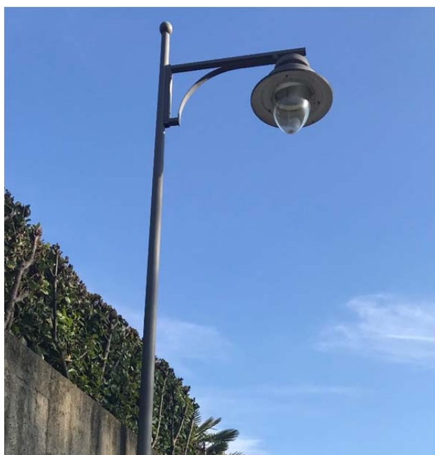
Armatura decorativa con vetro di chiusura curvo per lampada al sodio installata su palo con braccio decorativo
