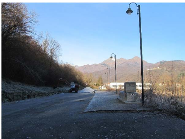
Punti luce di recente installazione con lampada al sodio ad alta pressione installati nell' area industriale Cascine
