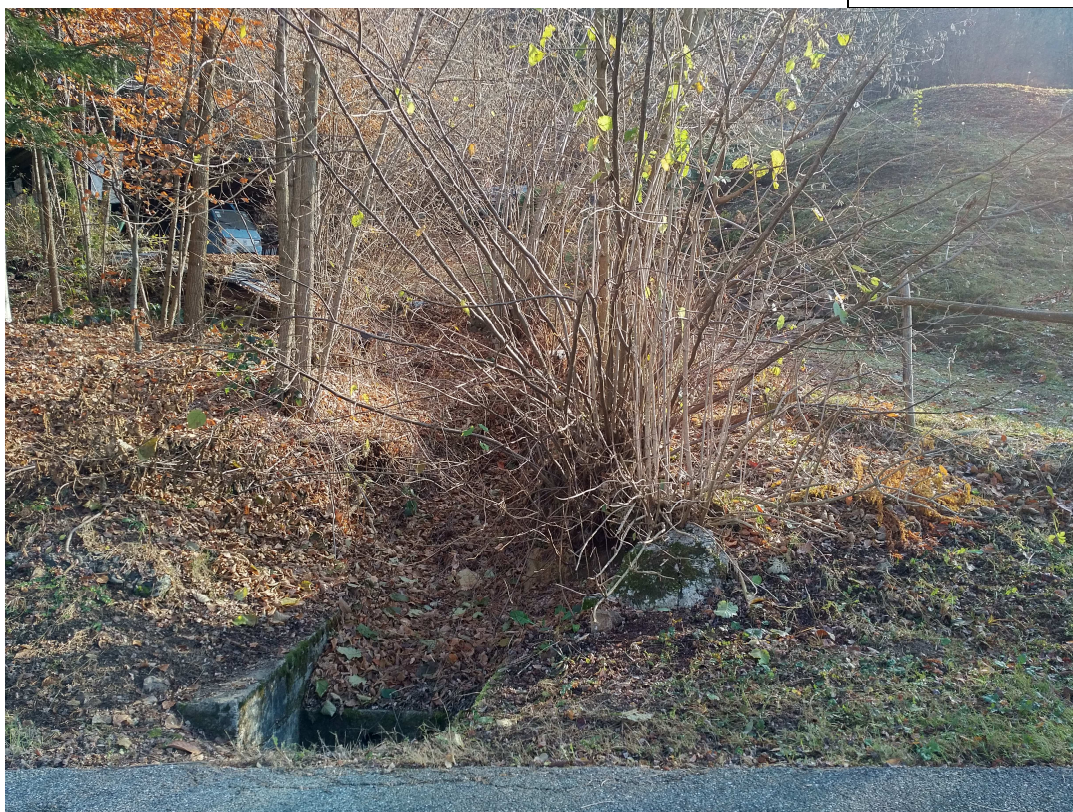
FOTO 7 – Panoramica del colatore recapitante in condotta a monte dell'area B23
