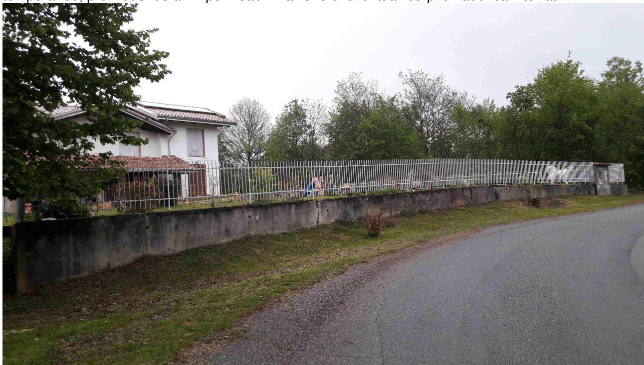
FOTO 11 – Panoramica del settore di strada comunale a monte dell'area B30
