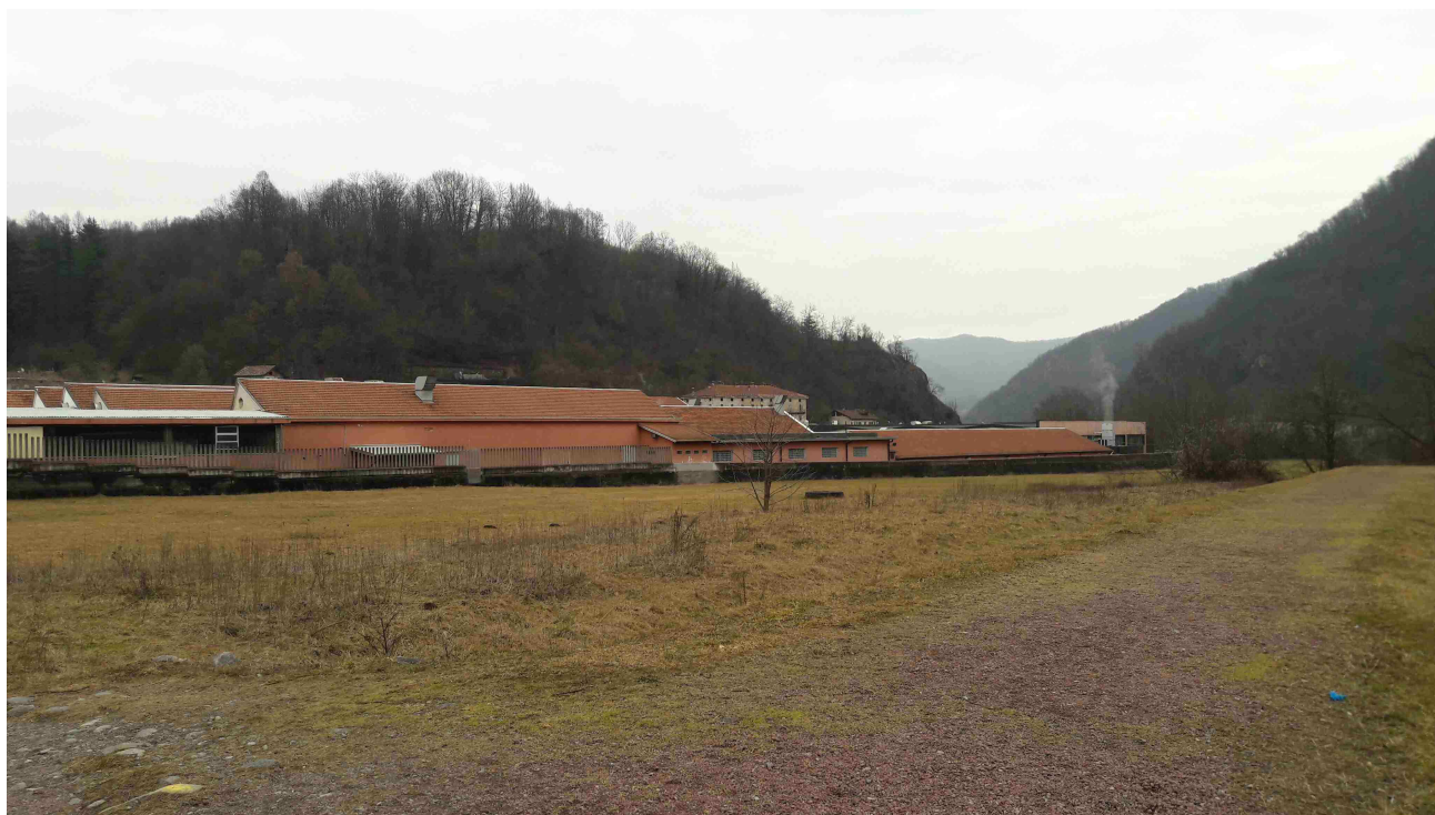
FOTO 21 – Panoramica dell'area DS4
