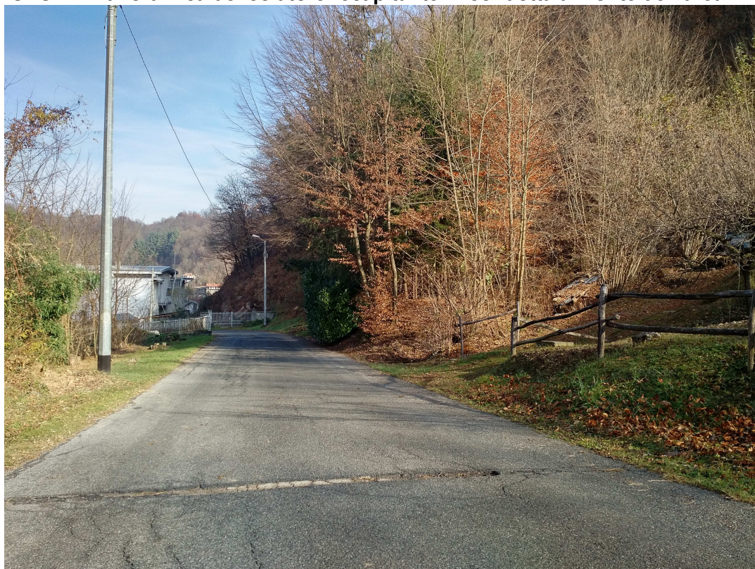
FOTO 8 – Panoramica del settore di strada comunale a monte dell'area B23
