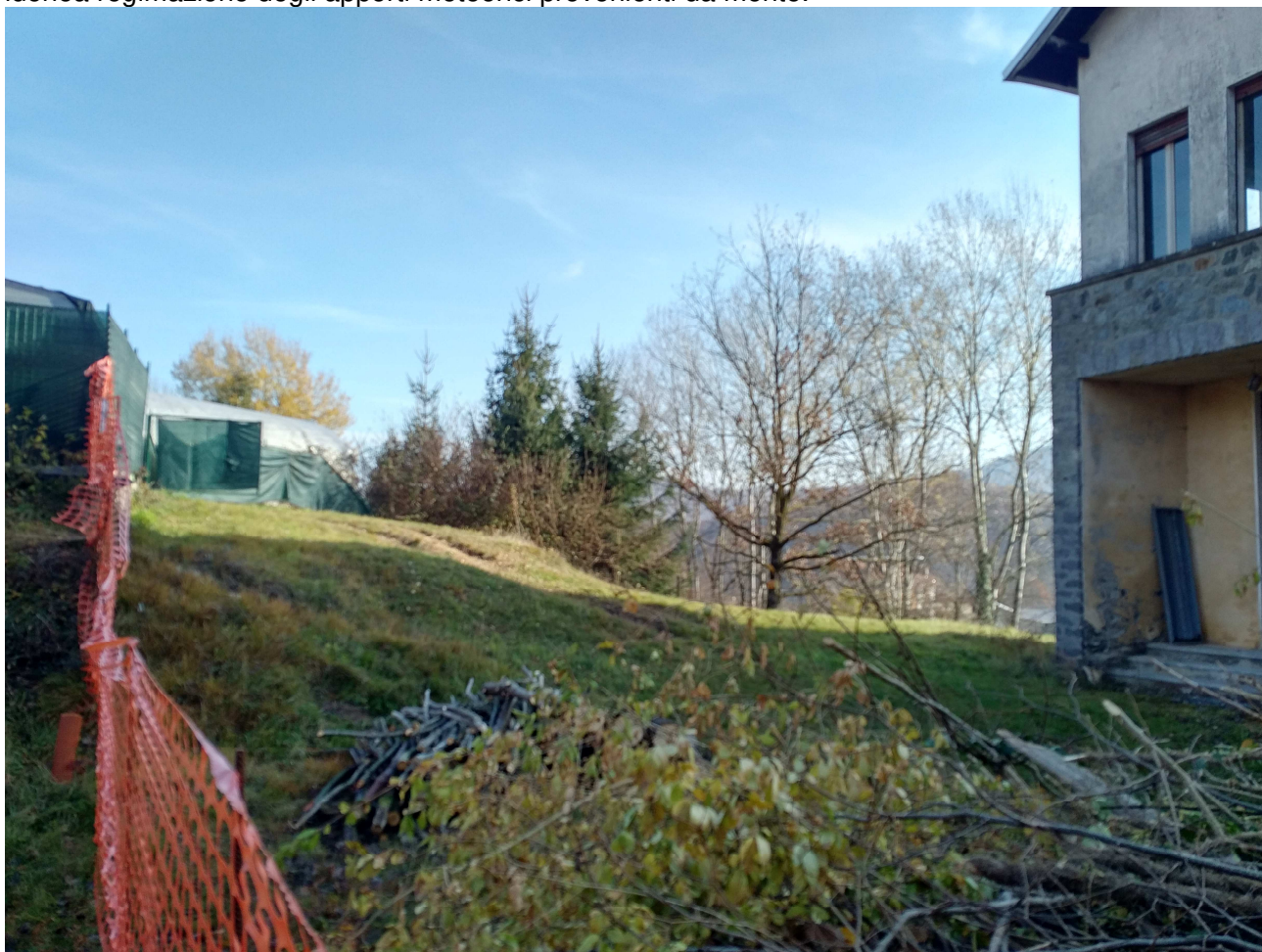
FOTO 9 – Panoramica del settore di strada comunale a monte dell'area B25
