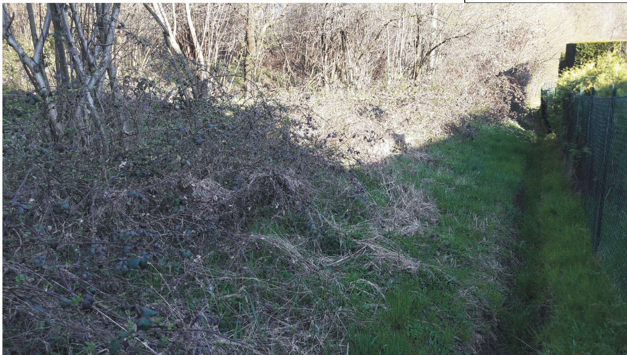
FOTO 28 – Fosso per la regimazione acque superficiali al margine orientale dell'area C1
