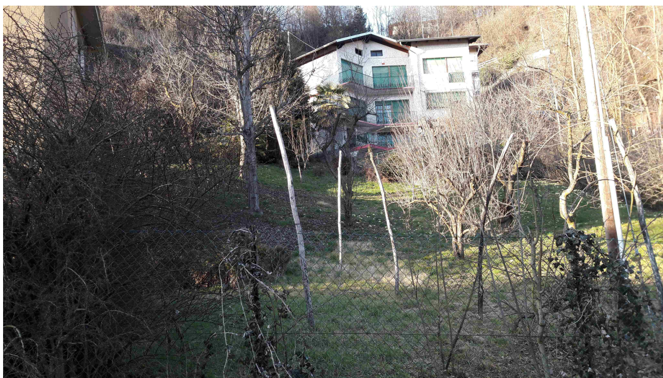
FOTO 1 – Panoramica dell'area B07
