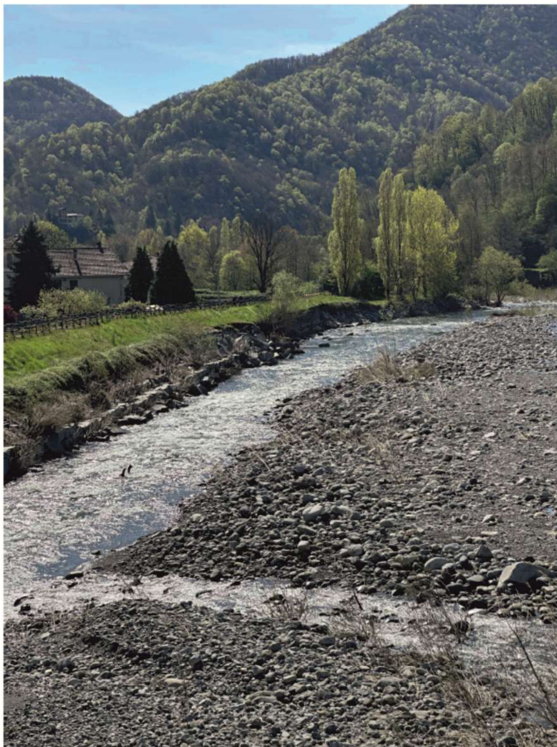
FOTO N. 2 - Vista da ponte in loc. Pianca protezione spondale in massi (scogliera) danneggiata
